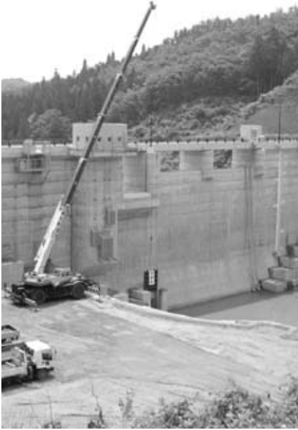
完成したダム堤体
